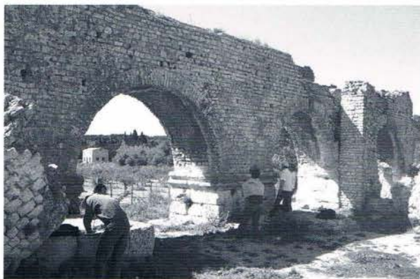
Une vue générale des ruines de l'aqueduc
