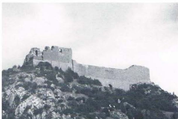
La face sud-ouest
