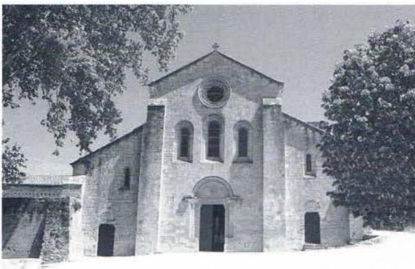
La façade ouest avec l'entrée
